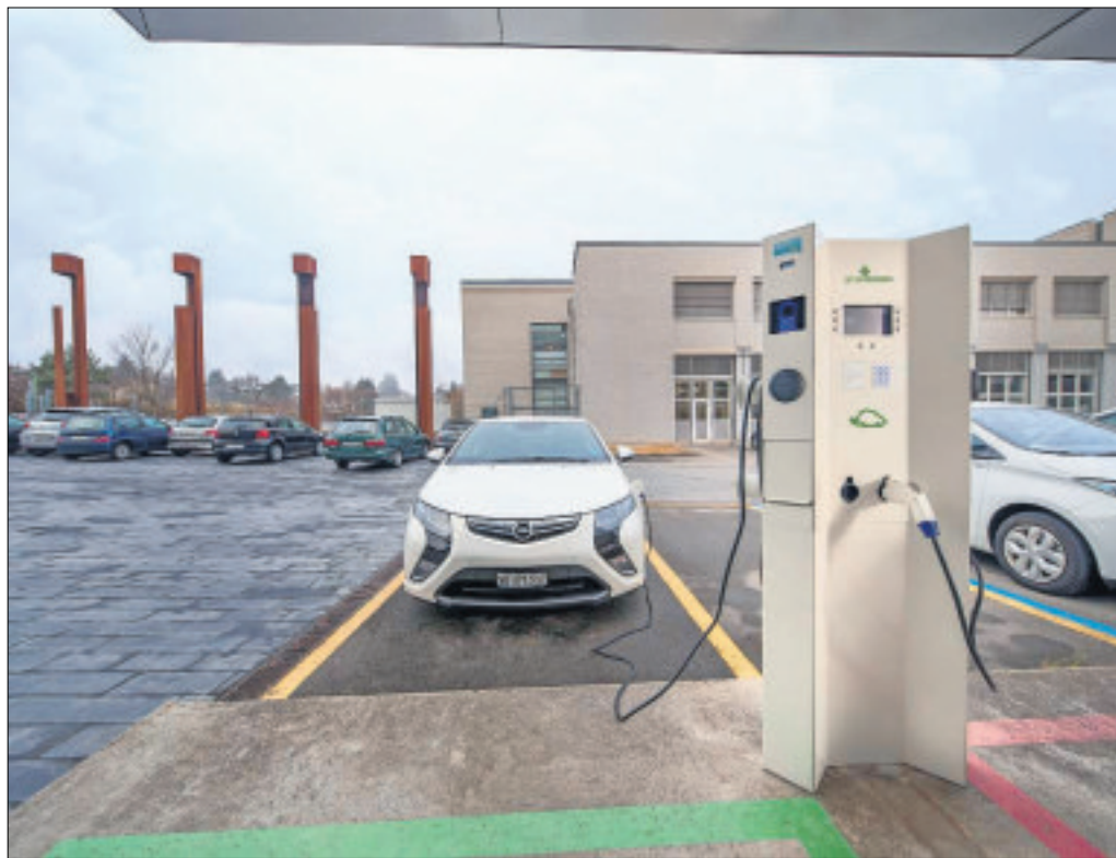
La société Sacen qui regroupe neuf communes jurassiennes veut pallier le manque de bornes publiques de recharge. Ici un modèle installé dans un autre canton.
